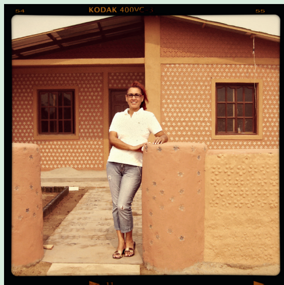
Ingrid Vaca Diez criou um projeto de construção de casas populares usando como base garrafas PET
